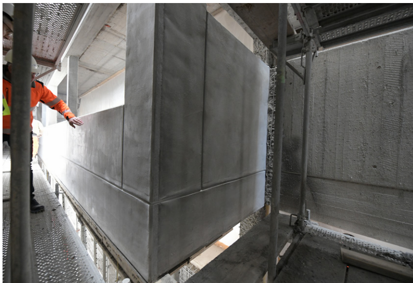
Les façades du bâtiment, inscrit au répertoire des biens culturels d'importance locale, sont reconstituées par l'application d'un mortier spécial sur 5 à 6 cm d'épaisseur, sur lequel des listes d'angle (encoches linéaires dans le béton marquant les différentes étapes et éléments de la structure tels que les dalles et piliers) sont ensuite façonnées. Sur la droite, on aperçoit l'ancienne façade avant hydrodémolition et traitement et, à gauche, la façade assainie et reconstituée.
