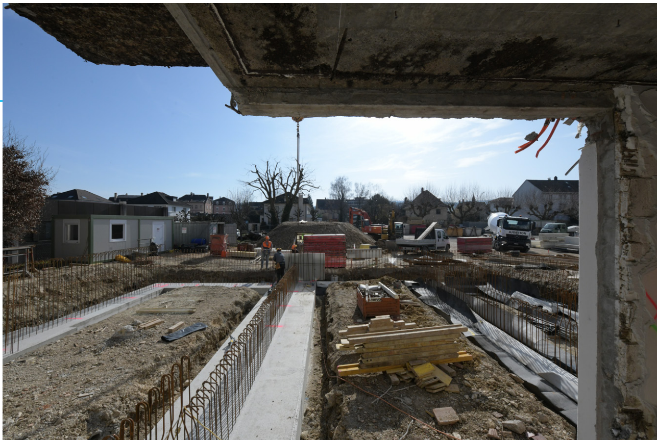
Les fondations en béton des futures nouvelles salles de sciences sont en cours de réalisation.
