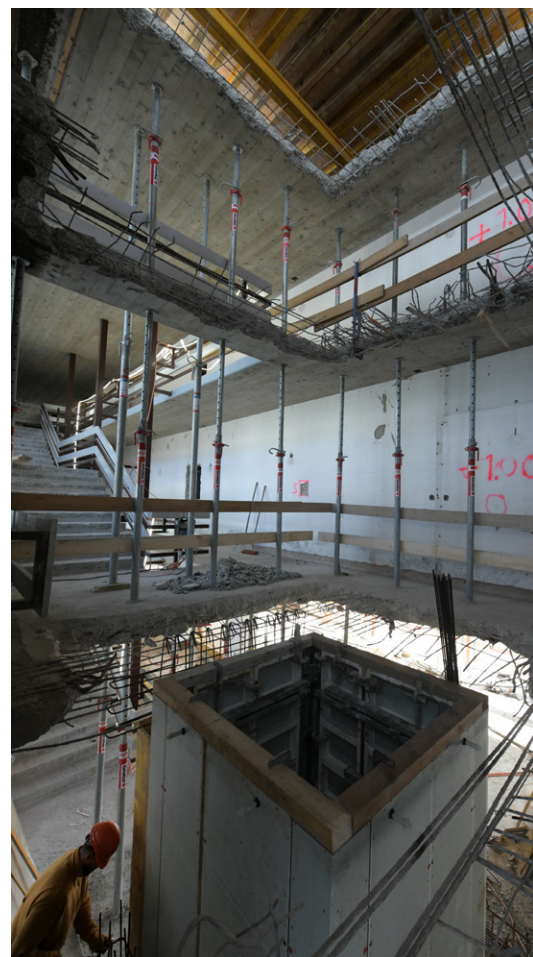
Une cage d'ascenseur est intégrée dans le bâtiment existant double : offrir, d'une part, un accès aux personnes à mobilité réduite en parallèle un effet de rigidification du bâtiment afin de répondre aux normes parasismiques actuelles.
