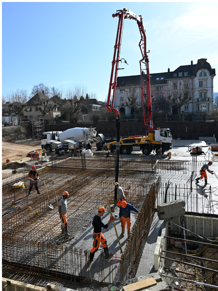
Les ouvriers procèdent au bétonnage de la première étape du radier (fondation en béton armé) des nouvelles salles de sport.
