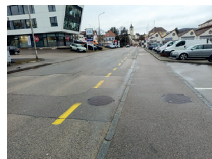
La route de Courgenay sera entièrement remise à neuf jusqu'au giratoire de la Patinoire.
